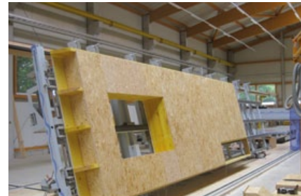
Alle Elemente laufen über die Fertigungsanlage, auch komplizierte wie bspw. die Fledermausgaube. Every component, even a round bat dormer, goes through the automated production.
