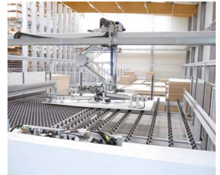
Die Säge-Lager-Kombination der Schreinerei Schneider AG in Pratteln besteht aus einer Säge HPP 530 und einem Flächenlager TLF 420. Beide Maschinen sind von Haus aus füreinander geschaffen.
